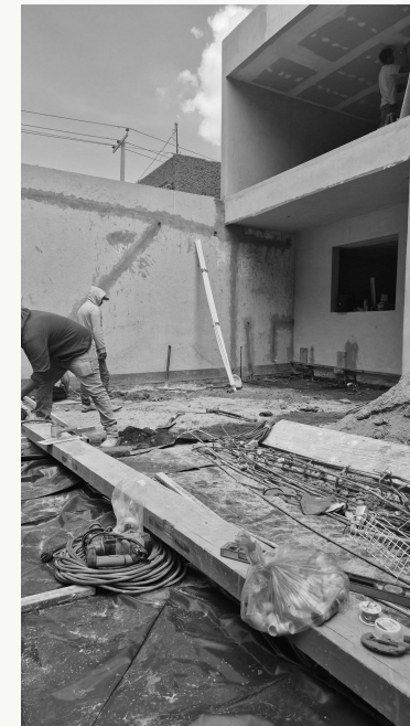
Registro del inmueble durante la intervención.
